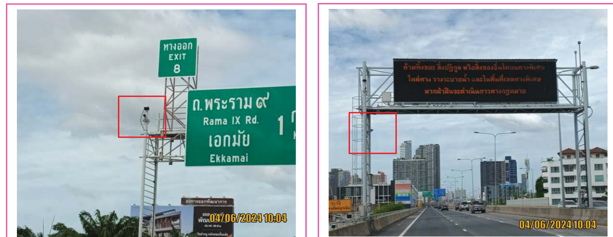
รูปที่ 3.2-13 กล้องโทรทัศน์วงจรปิด ตรวจจราจรวิ่งไหล่ทางพิเศษคลองรัช
